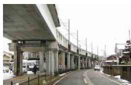
三条市の連続立体高架橋
