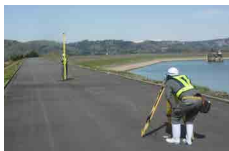
山本第二調整池の測量
