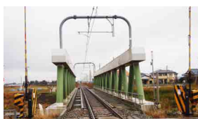
山倉川に架かる鉄道橋
