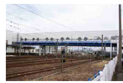
直江津駅の北口と南口を結ぶ自由通路（側面全景）
